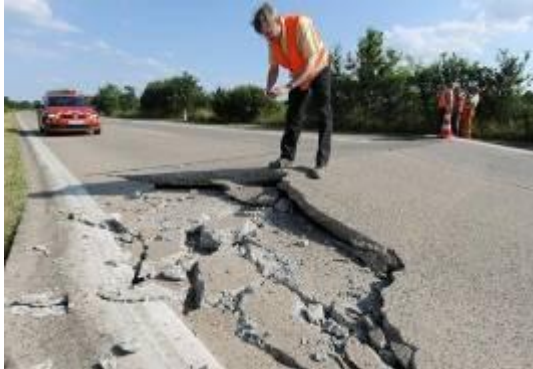
Abbildung 4: Beschädigte Betonplatten auf der A29 im Sommer 2010 3
