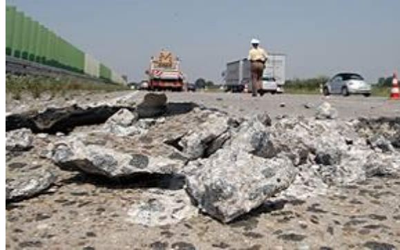
Abbildung 4: Beschädigte Betonplatten auf der A29 im Sommer 2010 3
