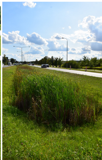
Rysunek 5. Rów bioretencyjny: Greendale, Wisconsin, Stany Zjednoczone (po lewej); Wilanów, Warszawa, Polska (po prawej)
