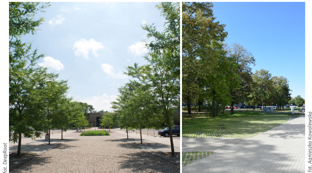
Rysunek 17. Przykłady zastosowania różnych rodzajów nawierzchni przepuszczalnych na placu przy Century College Stormwater Education Island, White Bear Lake, Stany Zjednoczone (po lewej); ażurowy parking przy Muzeum Sztuki Nowoczesnej, Warszawa, Polska (po prawej)
