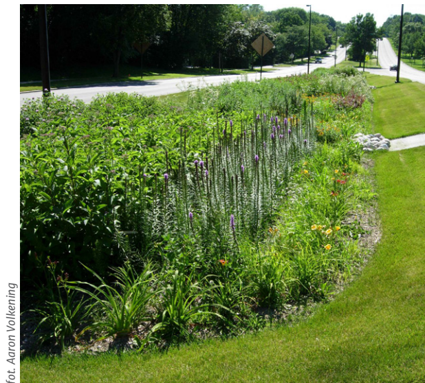
Rysunek 5. Rów bioretencyjny: Greendale, Wisconsin, Stany Zjednoczone (po lewej); Wilanów, Warszawa, Polska (po prawej)
