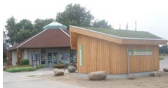
1.29 > Der Infopavillon befindet sich direkt neben dem Tourist-Service Kalifornien.
